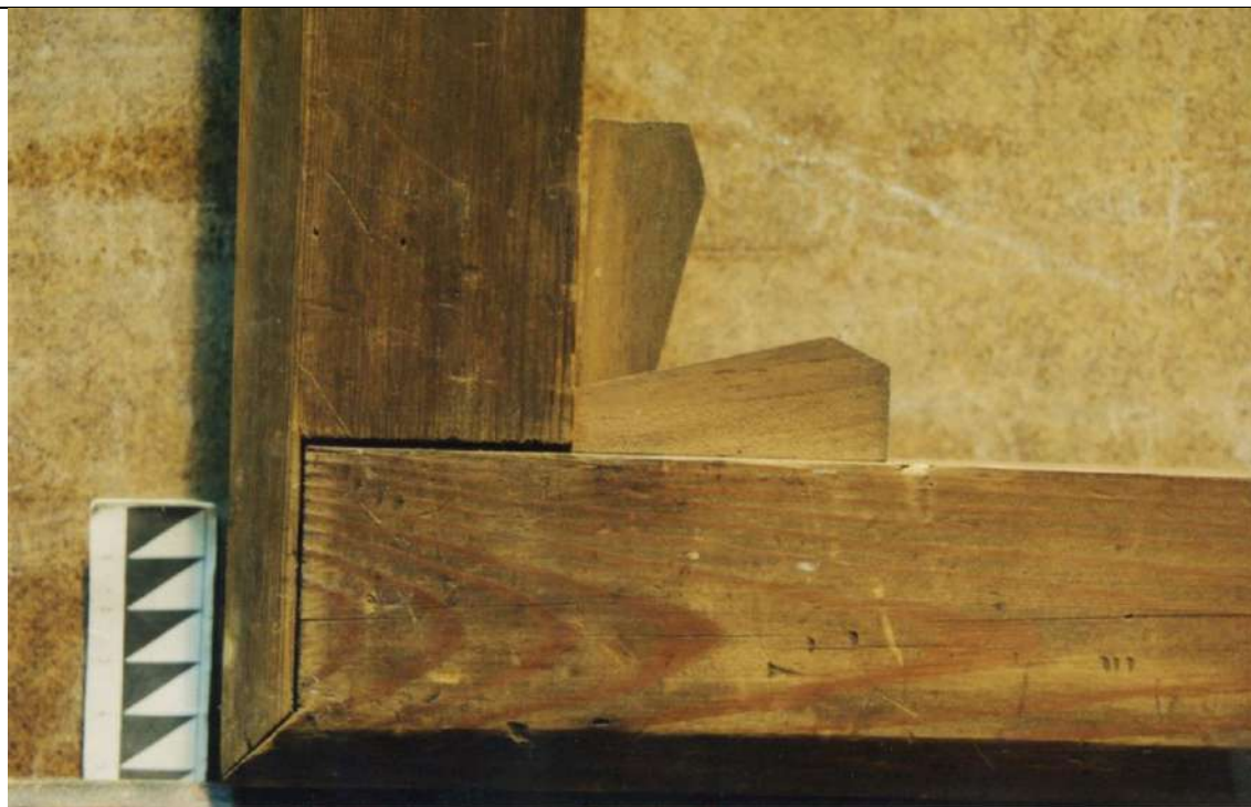
Скрытый шип. Подрамник типичный для 19-го века. На таких подрамниках написаны портреты Галереи 1812-го года в Эрмитаже. Такая конструкция считается самой лучшей.
