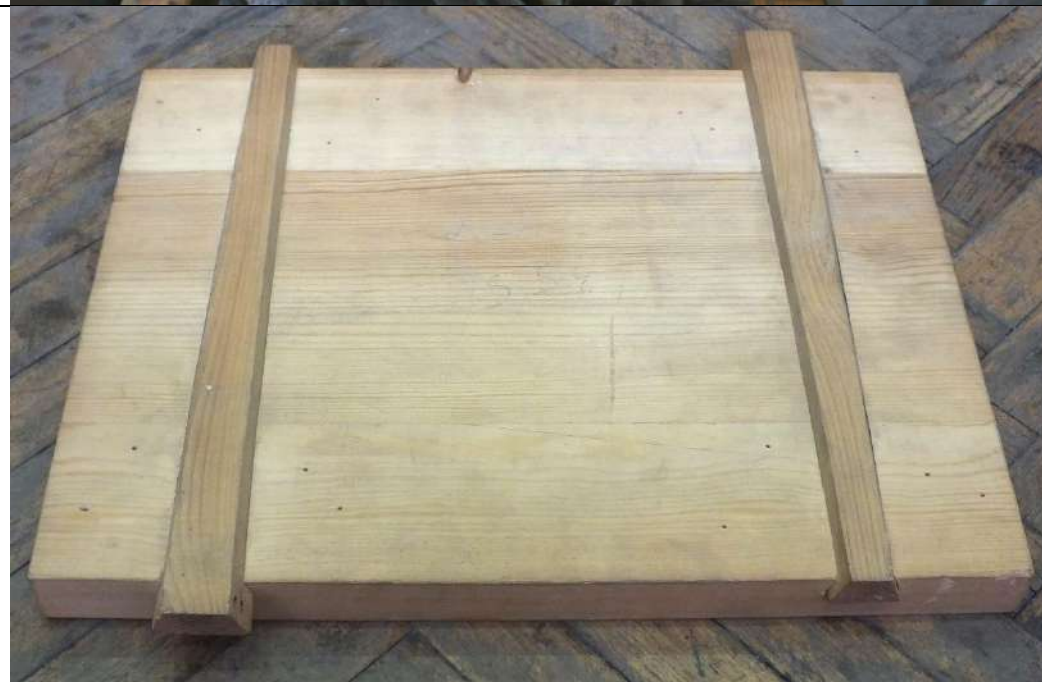
Примеры встречных сквозных врезных шпонок. (Тыльная сторона доски).
