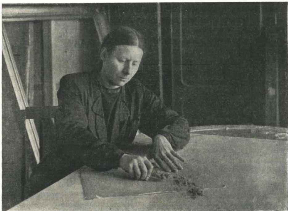
Рис. 21. Утоньшение картона
