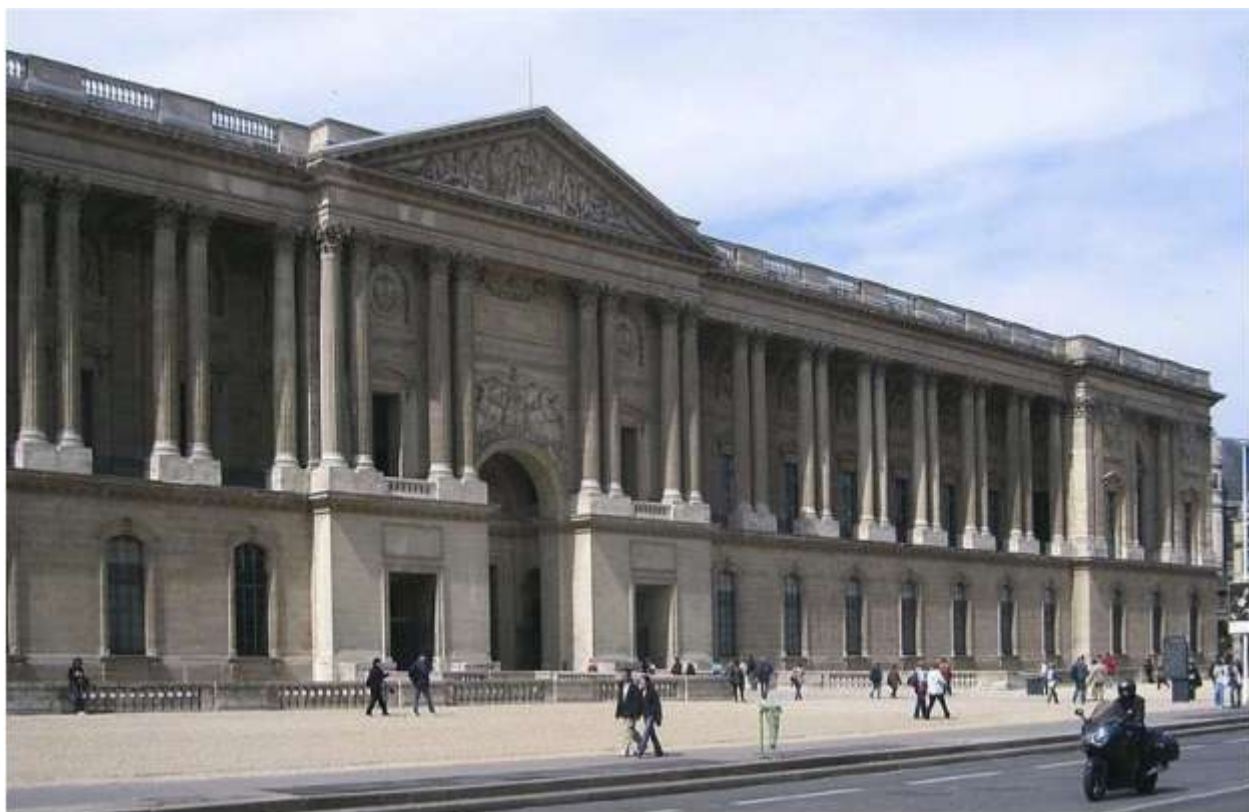
Рис. 39. Восточный фасад Лувра. 1667-1678. Клод Перро
